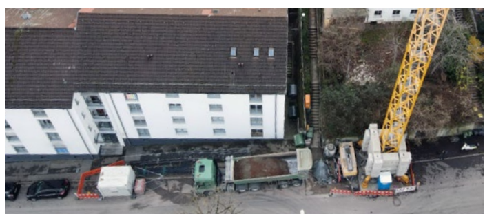
Beengte Verhältnisse erfordern eine sorgfältige logistische Planung.
